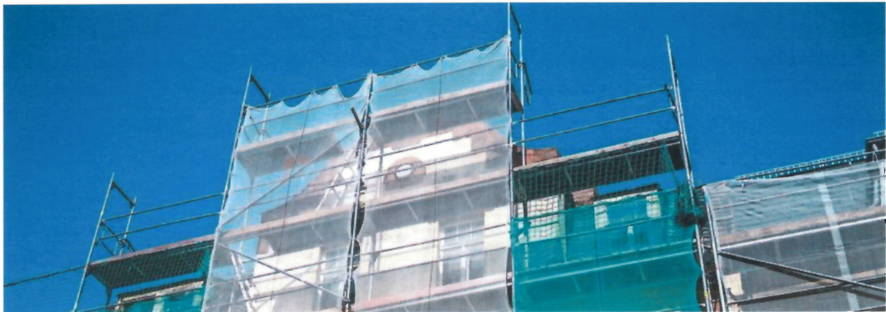
Der Freistaat wird in Hartha aktiv: Das Zentrale Flächenmanagement Sachsen hat das landeseigene Grundstück in der Goethestraße 10 absichern lassen.
